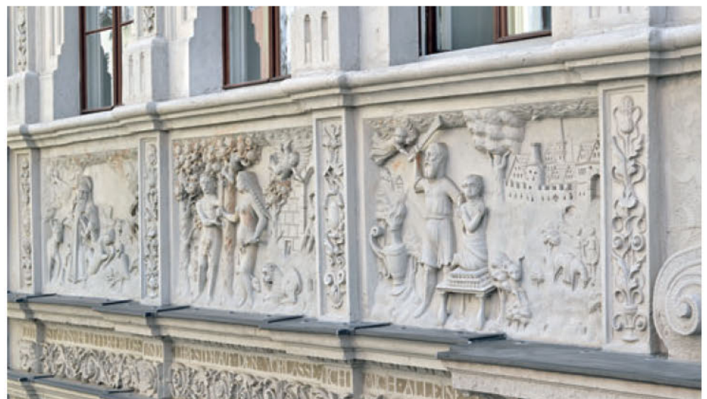
Fassade des Biblisches Hauses,
